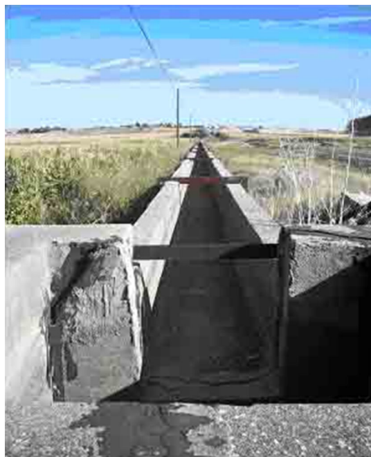
Projekt nr 22, modernizacja starych betonowych akweduktów poprzez system podziemnych rur i pomp w Hiszpanii.
