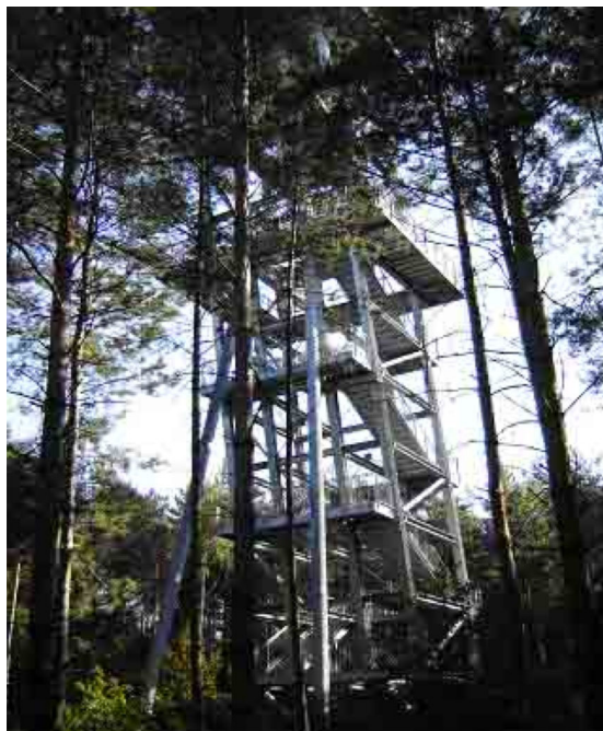
Projekt nr 15, budowa wieży widokowej w Brandenburgii.
